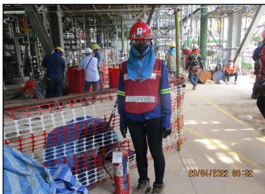
รูปที่ 2-22 อุปกรณ์ดับเพลิงและผู้เฝ้าระวังเพลิง
