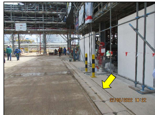
บ่อดักตะกอน และบ่อฟักตะกอนชั่วคราว
