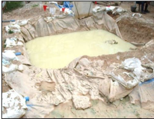
บ่อดักตะกอน และบ่อฟักตะกอนชั่วคราว
