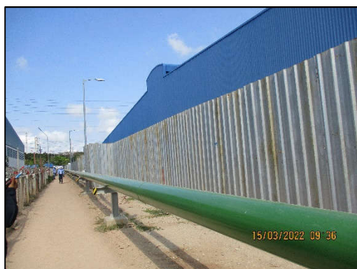
รูปที่ 2-6 การติดตั้งรั้วที่รอบแนวเขตพื้นที่ก่อสร้าง
