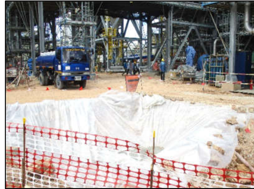
บ่อดักตะกอน และบ่อฟักตะกอนชั่วคราว
